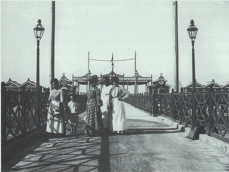
Pontile della piattaforma.
