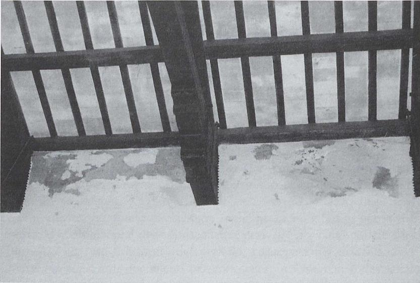
Figura 4. Parte alta della parete destra della Sala Grande: macchie di umidità, distacchi e cadute d'intonaco.
