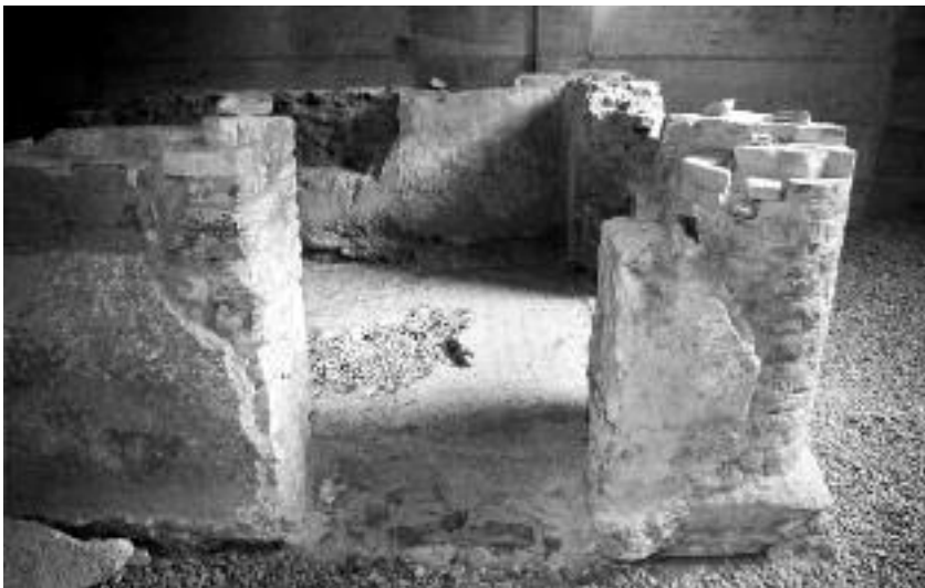
Figura 8: Tamponatura dell'atrium con murature continue intonacate internamente ed esternamente.
