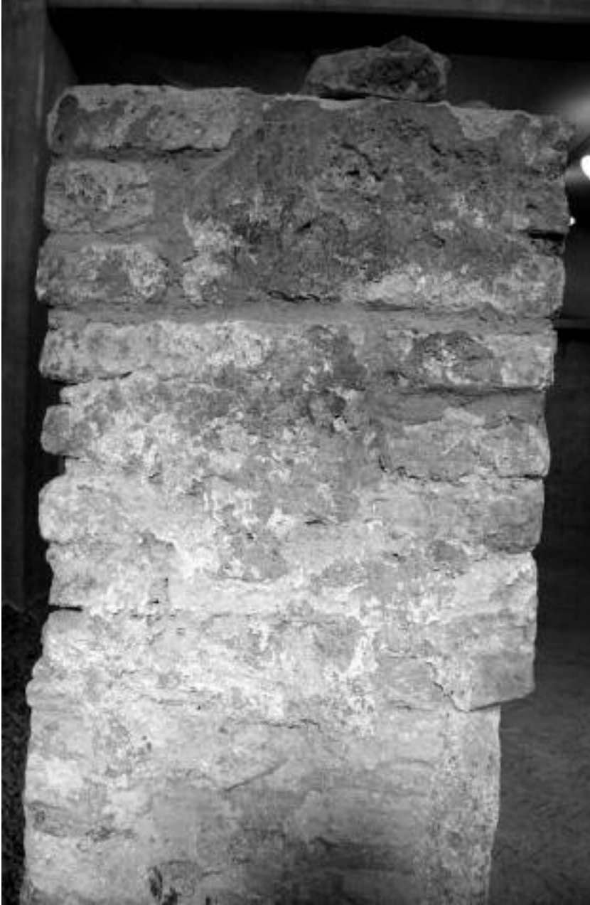
Figura 12: Tracce di intonaco di colore scuro sugli stipiti dell'accesso a nord-est.
