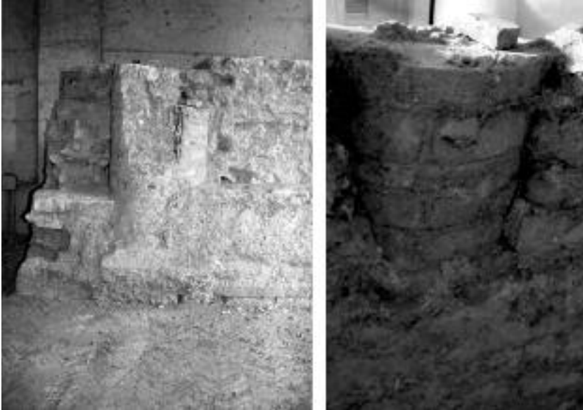
Figura 5: Colonna delimitante l'atrium visibile lungo il lato ovest dell'ambiente.
