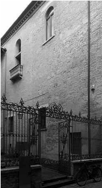
Figg. 44-45-46 - Dettagli fronte via Castracane
