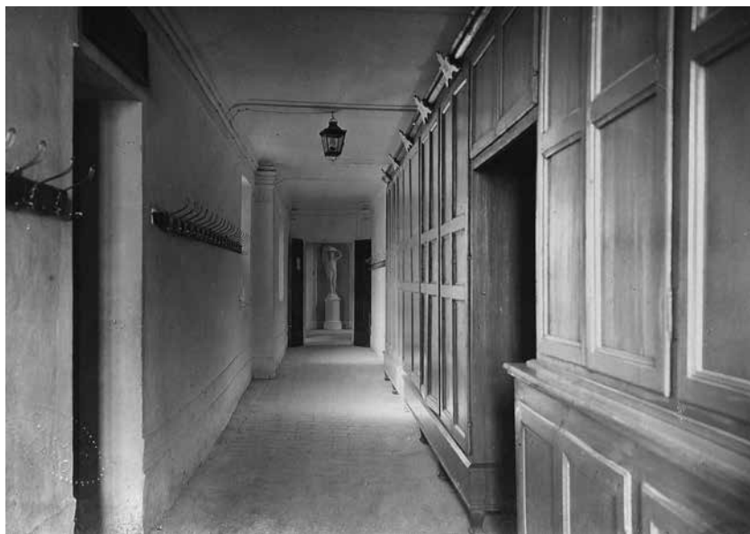
Fig. 47 - Interno biblioteca Federiciana. Archivio Biblioteca Federiciana di Fano
